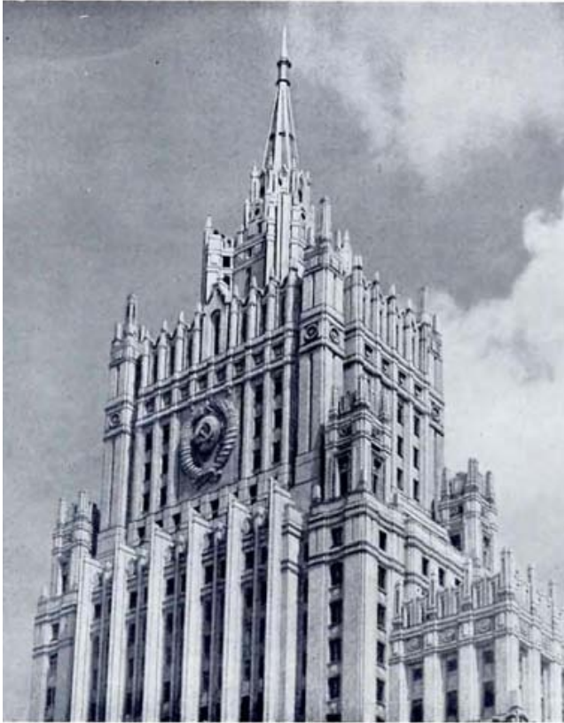
Фрагмент высотной части здания
